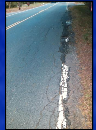
Edge Cracking
