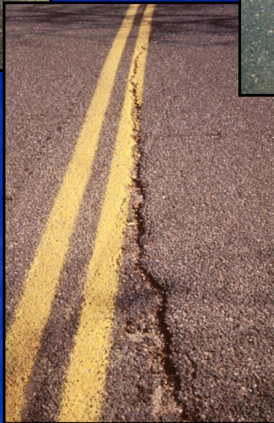
Longitudinal Cracking
